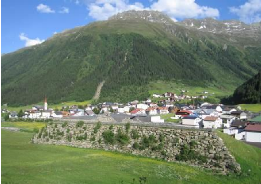
Figura 1. Ejemplo de dique de parada similar en Galtüer (Austria)
