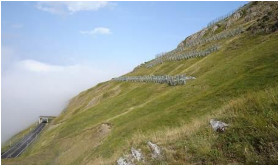
Figura 5. Barreras flexibles modulares instaladas para la protección de la carretera C142, de acceso a Beret (Valle de Arán).
