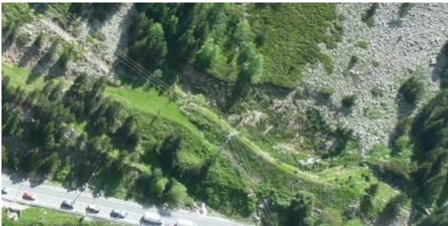
Figura 2. Dique actual visto desde el aire.
