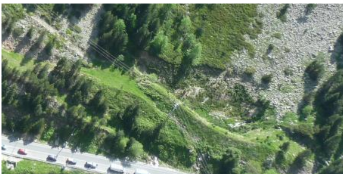
Figura 2. Dique actual visto desde el aire.
